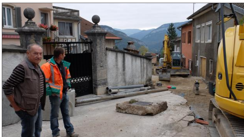
■ C'est l'entreprise Goyard de Chaux-des-Prés qui effectuera les travaux. Photo O.F
